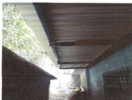
Foto 1: CUBIERTA DE LAMINA Y ESTRUCTURA DE TECHO
