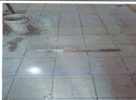
Foto 5: REPARACION DE PISO CERAMICO
