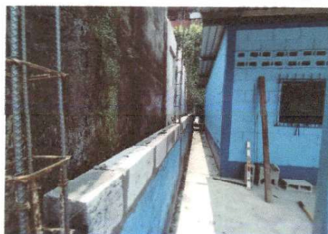
Foto 3: REPARACION DE MURO PERIMETRAL
