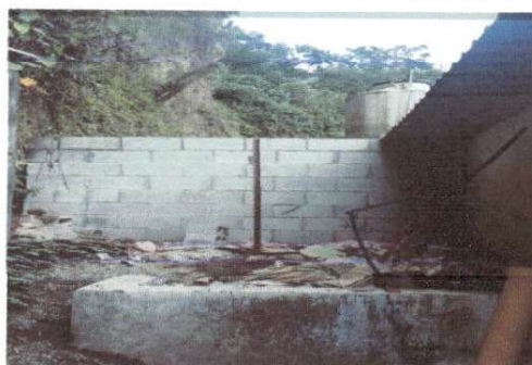
Foto 2: REPARACION DE MURO PERIMETRAL
