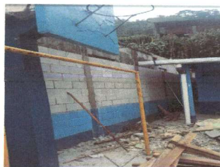
Foto 4: SUSTITUCION DE CANAL Y SUSTITUCION DE BARDA DE AGUA PLUVIAL DE METAR POR TUBO PVC 3"
